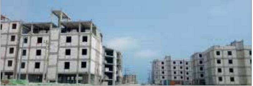
تصویر یک ساختمان در حال ساخت در یکی از مناطق هدف طرح مسکن ملی
